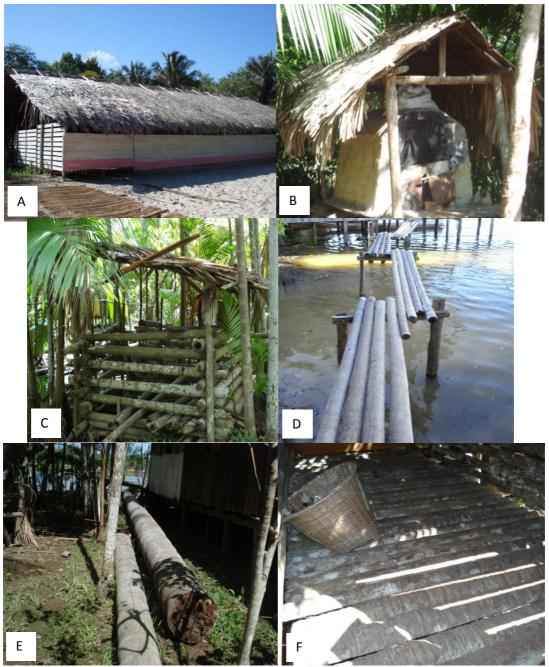
**Figura 8. A-B.** Utilização da palha do bussu/ palheira para a cobertura de barracões e depósitos; **C**. Caule do açaí para construção de depósito/ casas dos animais; **D**. Idem para a construção de pontes; **E**. Caule da paxiúba para assoalhar depósitos; **F**. Caule do miriti utilizado como ponte.
